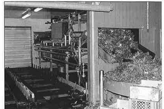
Bild 3: Blick von der Packstation in den Lagerbereich mit Eiswasser-Waschanlage und Transportsystem
