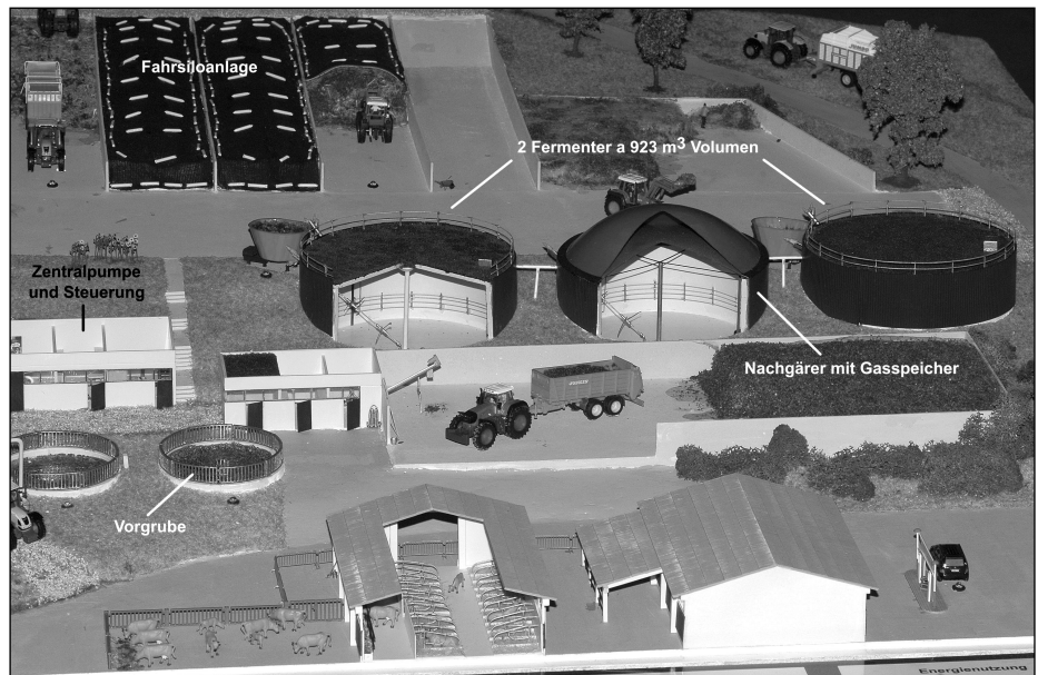
Bild 1: Modell der Biogasanlage „Unterer Lindenhof“
