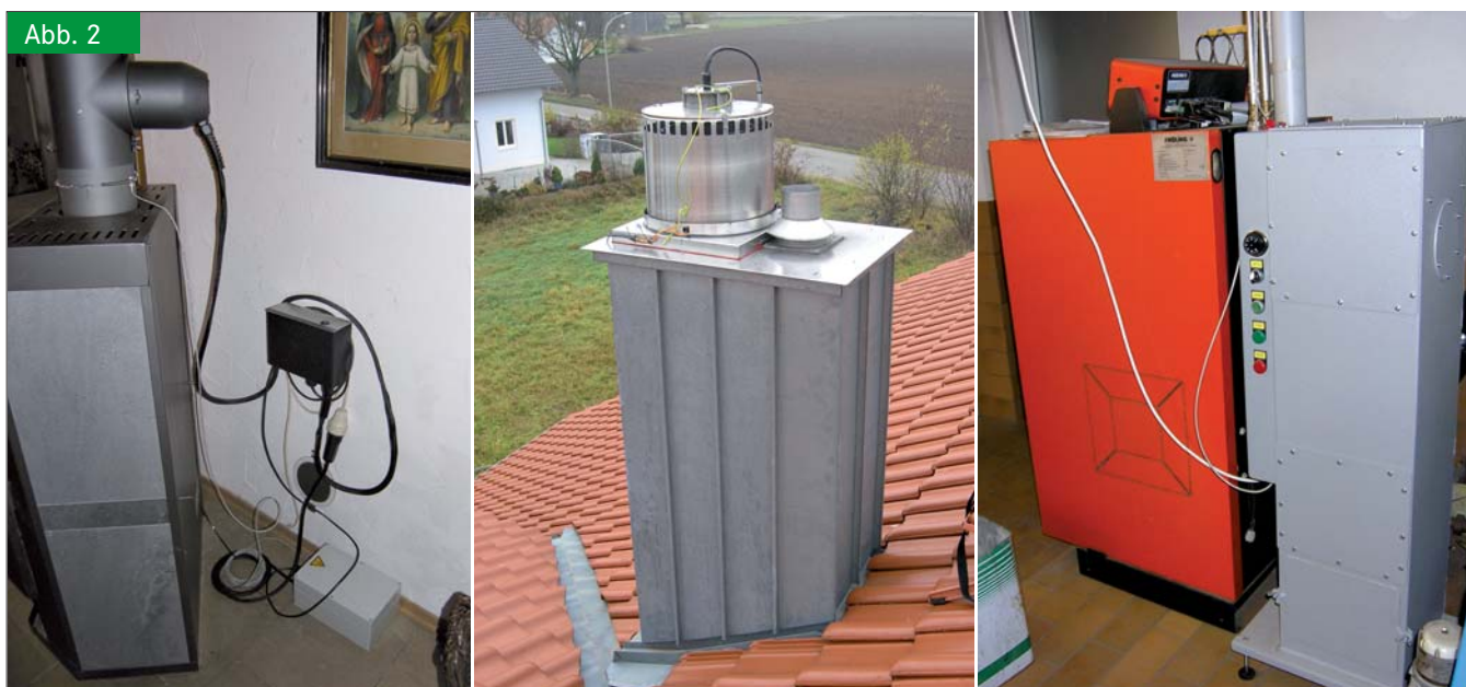
Beispiele für den Abscheidereinbau im Feldversuch; links: Zumikron im Ofenrohr eines Kaminofens, Mitte: APP R_{\text{residential}} ESP auf Schornsteinmündung, rechts: Spanner SFF20 an Pelletkessel. Fotos: TFZ Fig. 2: Examples of precipitators used in field tests; left: Zumikron in flue gas pipe of a stove; middle: APP R_{\text{residential}} ESP in chimney top; right: Spanner SFF20 with pellet boiler
